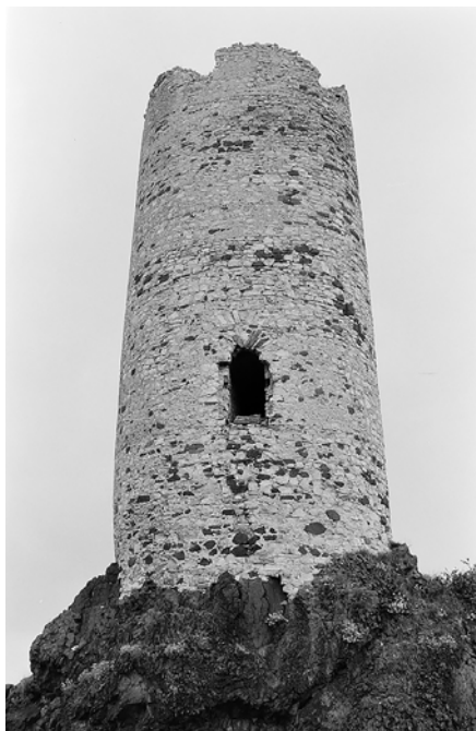
Skalka (okr. Litoměřice), okrouhlá věž hradu se vstupním otvorem v úrovni druhého podlaží. Stav 22. května 1996, foto autor.
