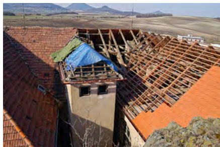
Skalka (okr. Litoměřice), prostor dvorku pod hradní skálou mezi dvěma zámeckými křídly, do něhož byl vložen v roce 1959 přístavek s výtahem. Stav 21. března 2009, foto autor.
